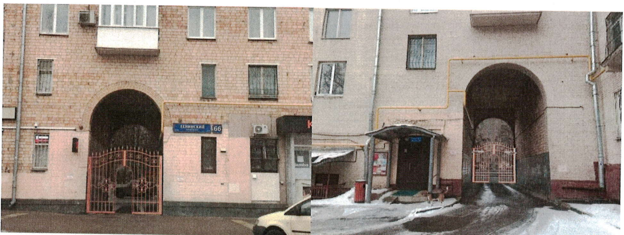
Левый въезд на территорию МКД
